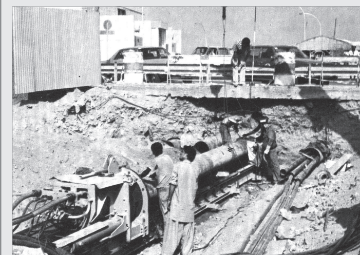
انشاء محطات تقوية وتمديد الكوابل لتوصيل الكهرباء
