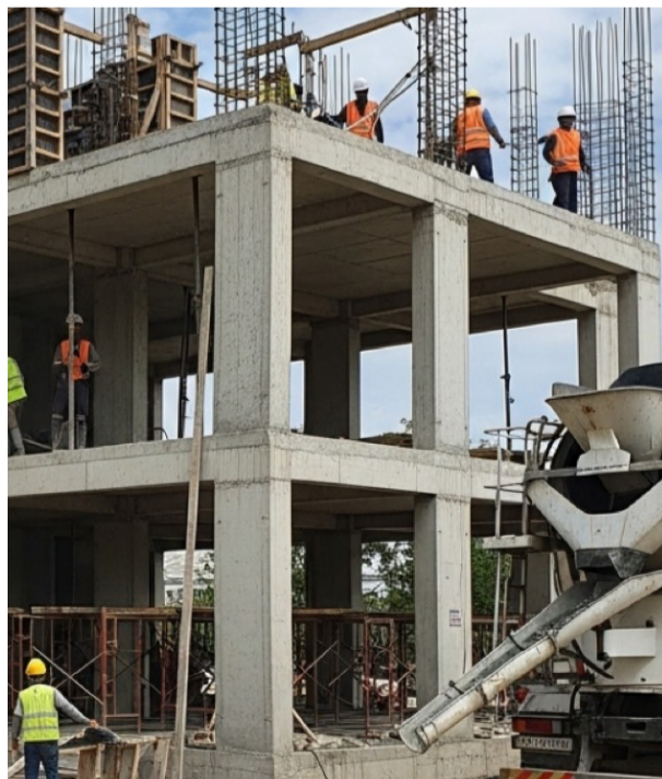
عمال بناء اثناء عملهم في التشييد
