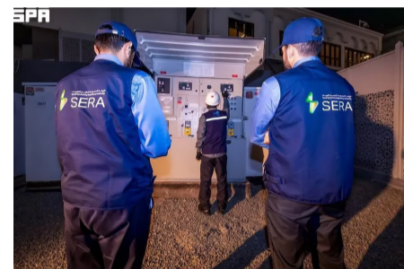
مهندسون من شركة الكهرباء أثناء عملهم في المشاعر
