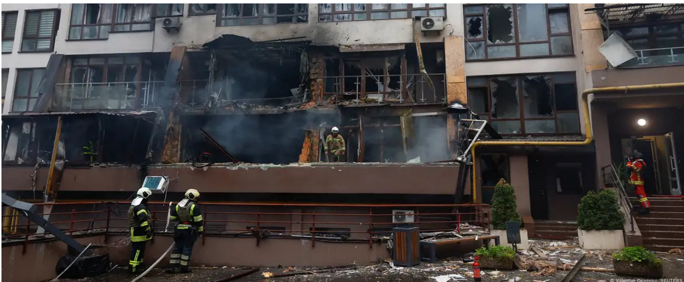
رجال إطفاء يخمدون النيران في مبنى تعرض للقصف بمسيرة روسية في كييف
