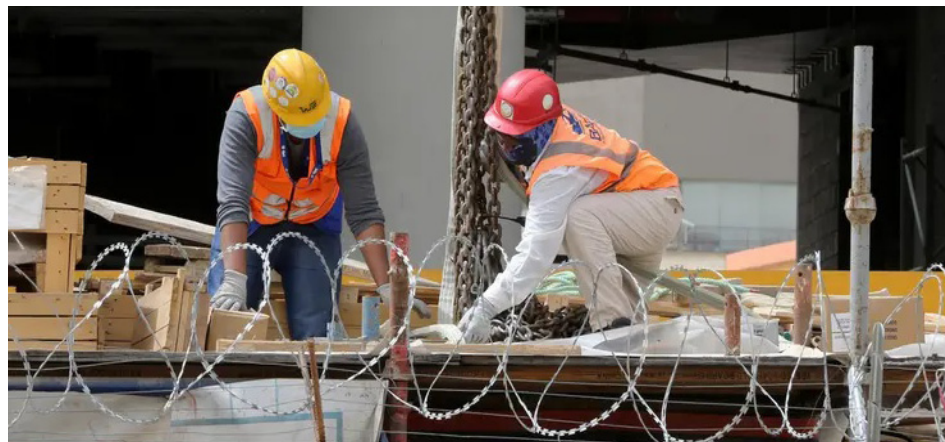
عمالة وافدة أثناء أعمالهم
