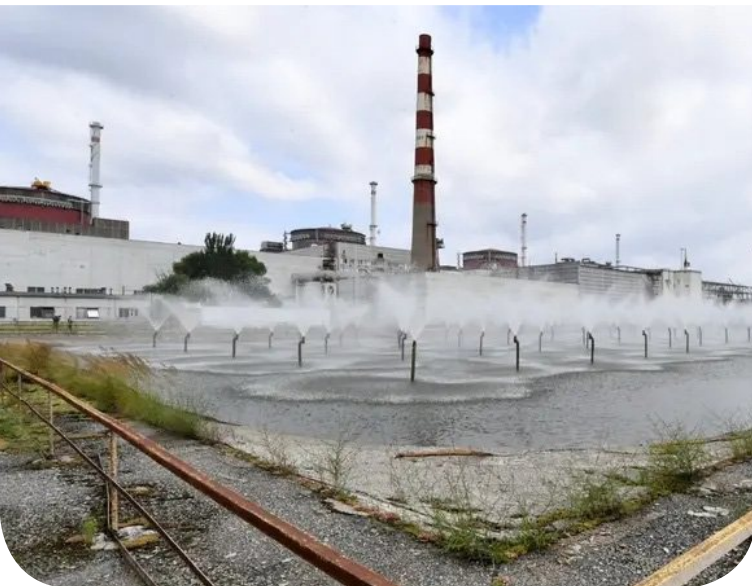
محطة زابوريجيا النووية جنوب أوكرانيا
