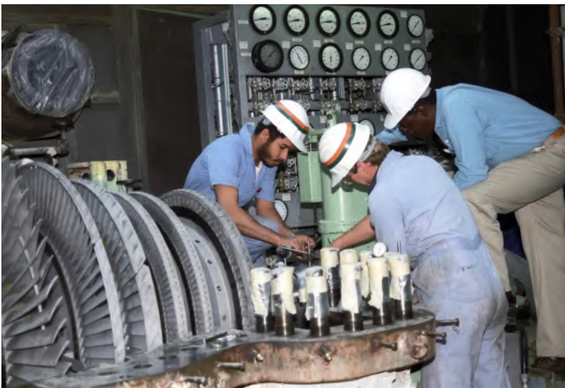
مهندسو كهرباء أثناء العمل
